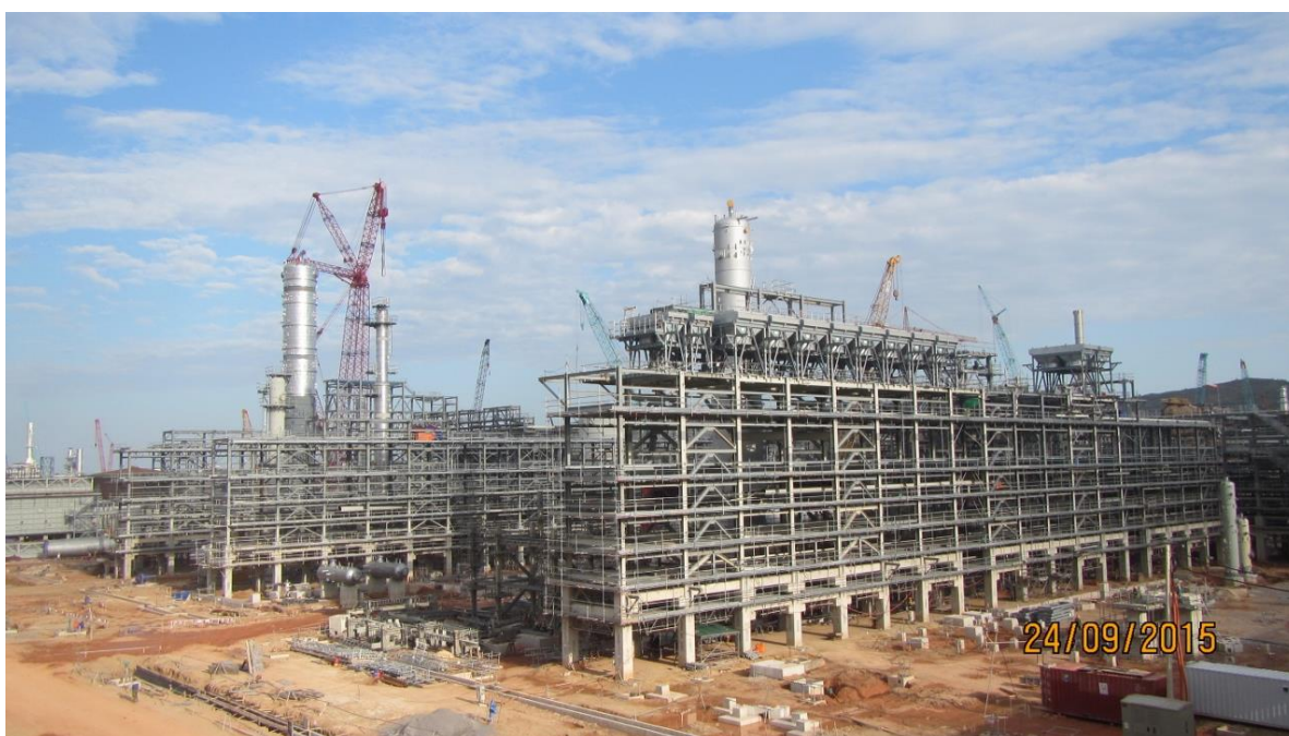
写真 建設中の Nghi Son 製油所 （出所：NSRP）
