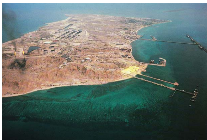
図8 カーグ（Kharg）島の石油ターミナル
