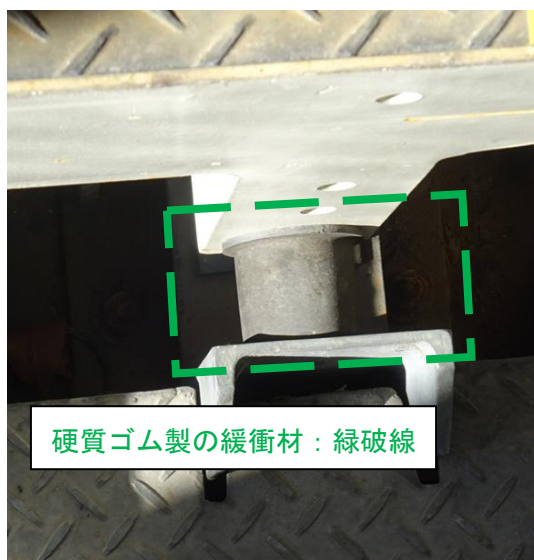
図7-10 移動式ステージのレール両端部への緩衝材
