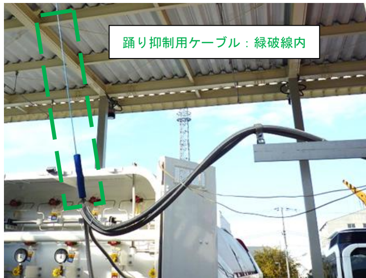
図 7-22 フレキシブルチューブ踊り抑制用ケーブル設置
