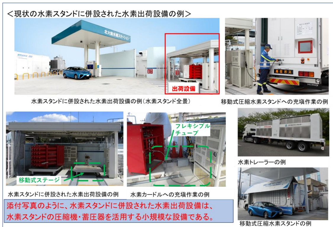
図 5-1 現状の水素スタンドに併設された水素出荷設備の例
