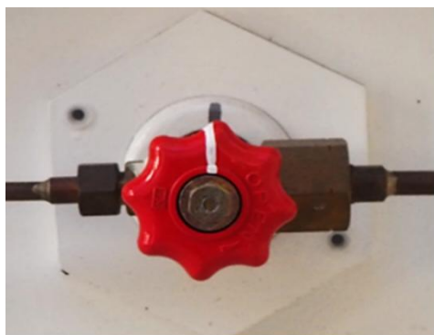
充填容器元弁が閉止
