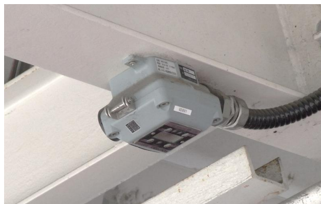
図 7-4 漏えい検知器
