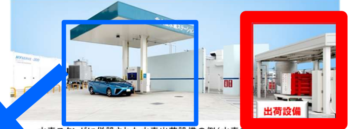
＜現状の水素スタンドに併設された水素出荷設備の例＞
