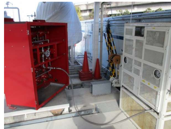
水素カードルへの充填作業の例
