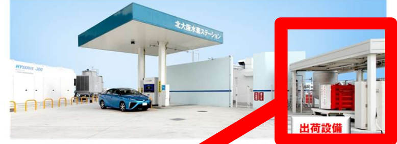
水素スタンドに併設された水素出荷設備の例(水素スタンド全景)
