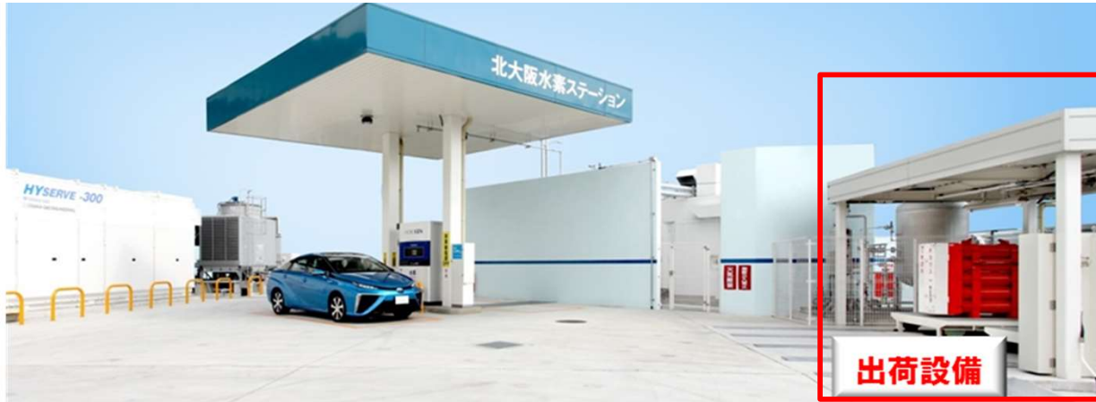
水素スタンドに併設された水素出荷設備の例（水素スタンド全景）
