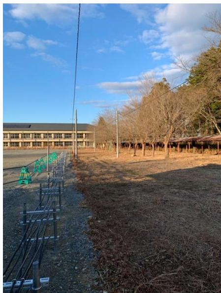
図 2-1-1 電柱に敷設した水素パイプライン(福島県浪江町にて実証実験中;研究者撮影)
