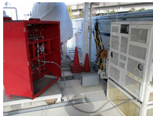
水素カードルへの充填作業の例
