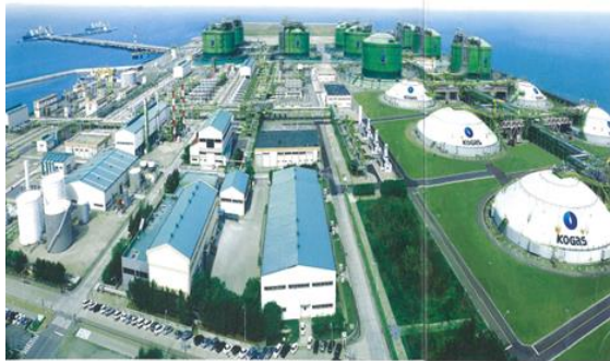
仁川 LNG ターミナル全景
