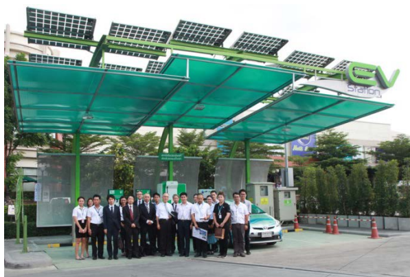
EV ステーション
